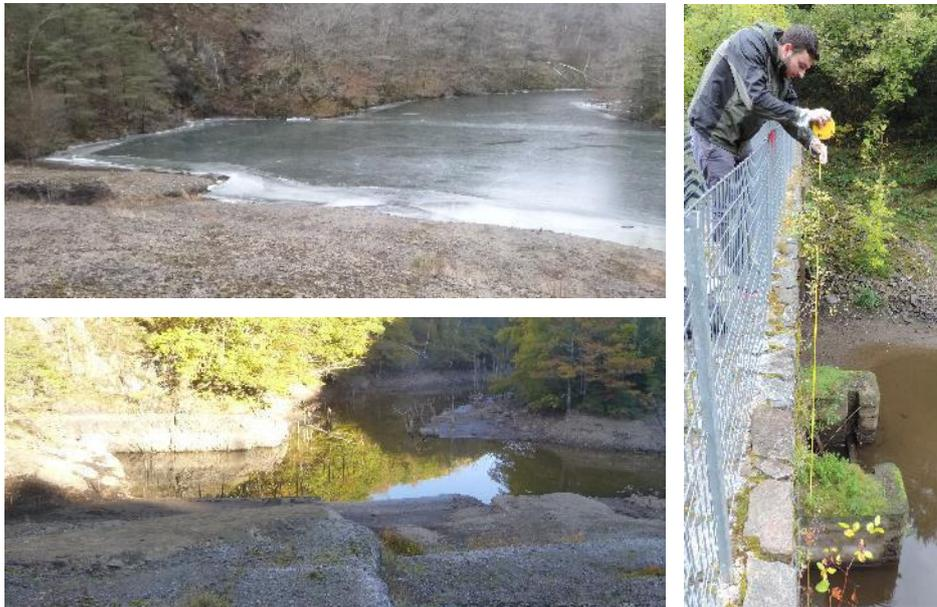
*En haut : barrage avant vidange, en bas : barrage pendant vidange, à droite suivi des hauteurs d'eau au niveau du pré barrage*
