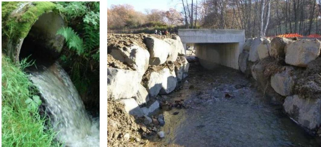
A gauche : buse de Combas avec sa chute 65 cm / A droite : remplacement par un pont à fond ouvert
